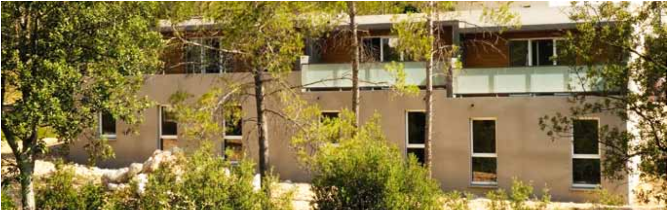
Chantier Cellumat : La Valène, Saint Gély du Fesc
