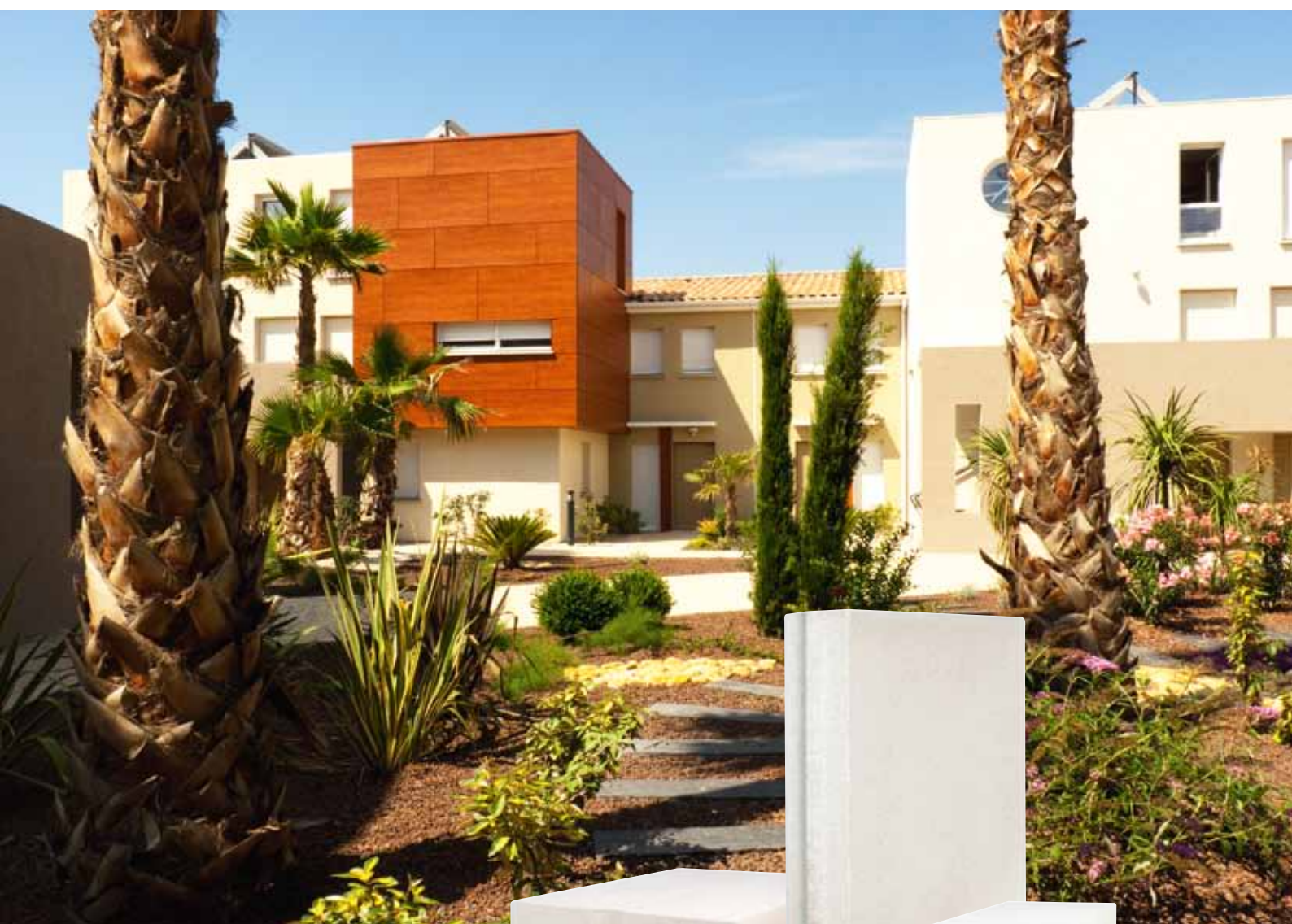
Chantier Cellumat : Les Jardins D'Anette – Mauguio
